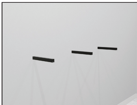
②壁材を施工します。
